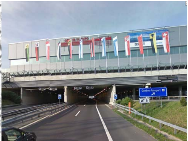
Bsp.: GE N01 Palexpo – Baulinien parallel zur Strassenachse, teilweise fehlend, keine vertikalen Begrenzungen.
